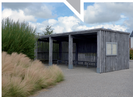
Milizac abri-vélos et clôture en fascines
