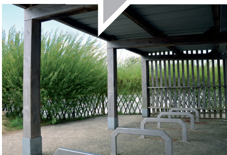
Milizac abri-vélos et clôture en fascines
