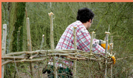
Tresse * finale et ajustement des piquets
