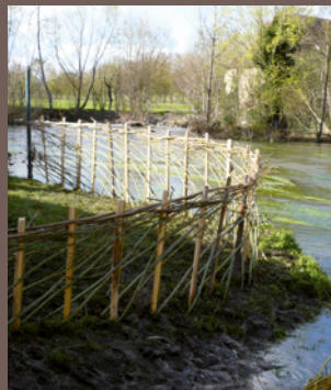
Maintien de berge Asnières-sur-Vègre (72)
