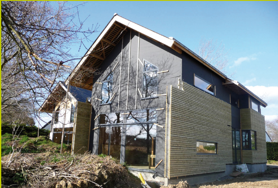
Habitat groupé bioclimatique - Saint-André-des-Eaux (44). Architecte : Rachel GARNAUD
