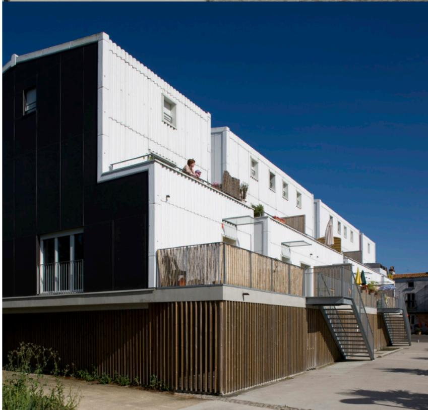
Inondables, les rez-de-chaussée sont des garages, clos de planches de bois formant claustras transparentes. Au-dessus, un socle de béton supporte les logements à ossature de bois, recouverts de bardages de fibre de ciment, blancs et ondulés pour la plupart des élévations, bleus ou rouges pour certains pignons, noirs pour les façades donnant vers la Loire, diminuant ainsi l'impact du projet dans le paysage de la rive. Les escaliers extérieurs, garde-corps et marquises, sont en métal galvanisé.
